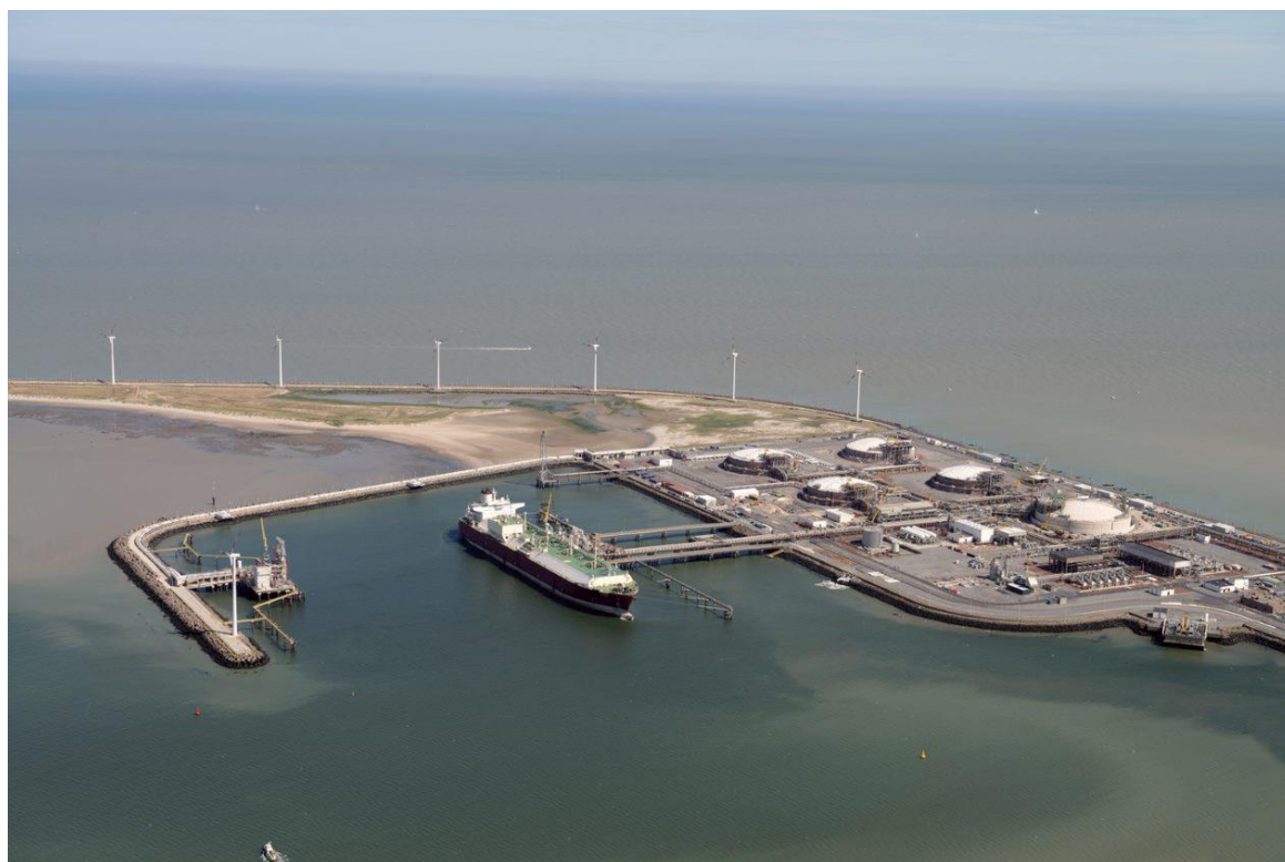
Illustration 2.1 Terminal GNL de Zeebrugge
