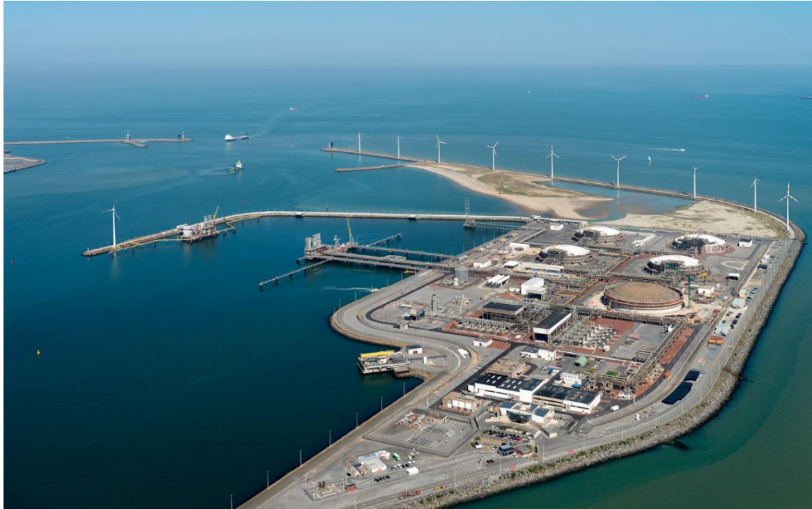
Figuur 2.1 Zeebrugge LNG Terminal
