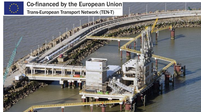
2nd jetty Zeebrugge LNG terminal
