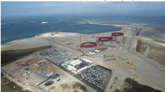
LNG-terminal Duinkerke in aanbouw
