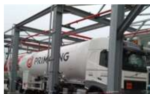
LNG road-tanker filling station at the Dunkirk LNG terminal
