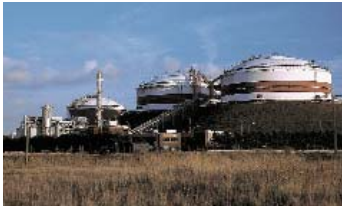
Bovengrondse aardgasopslag: piekbesnoeiingsinstallatie Zeebrugge
