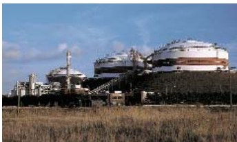
Stockage de gaz naturel en surface : l'installation d'écrêtement des pointes à Zeebrugge
