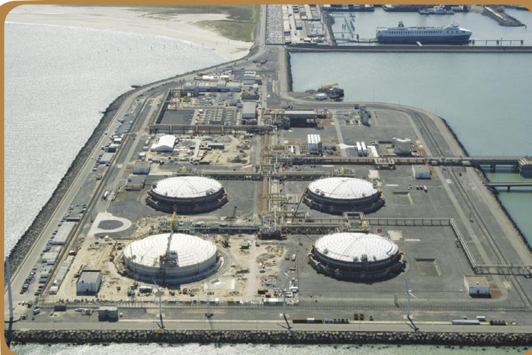
The current LNG terminal facilities
