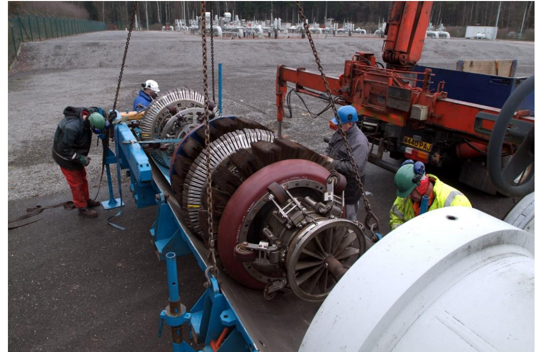
Interne inspectie van de leidingen
