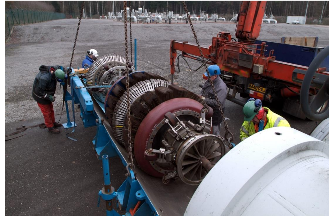
Interne inspectie van de leidingen
